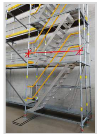
Abb. 4.7-36: Baugerüst mit zeichnerischen Ergänzungen
